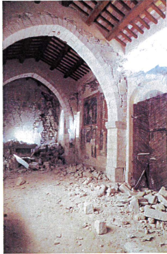
Figure 15-16 Chiesa di S. Martino dei Gualdesi a Castelsantangelo sul Nera. La spinta degli archi interni, non contrastata, ha portato al parziale ribaltamento del muro laterale, che si è "liberato" dal cordolo soprastante. Affreschi e portale sono stati danneggiati.
