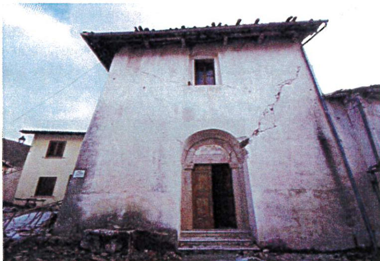
Figura 4 Facciata esterna della chiesa di S. Procolo ad Avendita di Cascia (PG)
